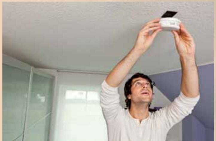
Dank Magnetklebepad lassen sich manche Rauchwarnmelder innerhalb von 30 Sekunden an der Decke installieren.
